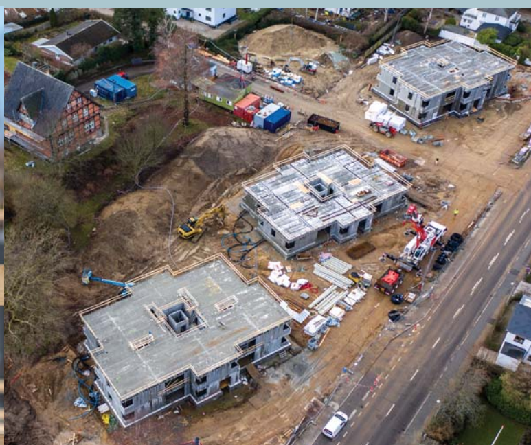
Mørdrupvej 15-19, Espergærde Opførelse af 35 eksklusive lejligheder i totalentreprise for Initus Ejendomme A/S.
