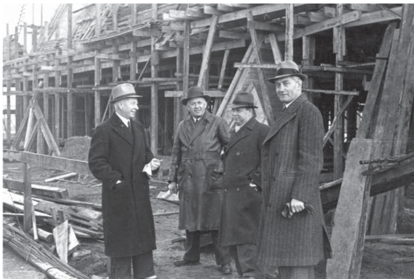
Einar Kornerup (t.v.) ved byggeriet af H. C. Ørstedsværkets nye turbinehal 1952.
