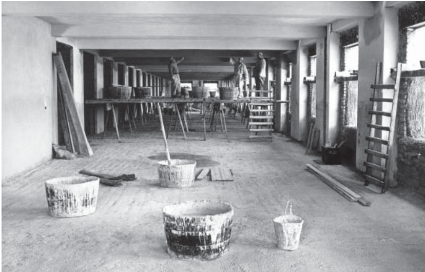
Rum under et af de nystøbte dæk ved opførelsen af Frederiksberg Rådhus i vinteren 1949-50. Som led i vinterbyggeri-forsøget blev det drøftet at opvarme rummene.
