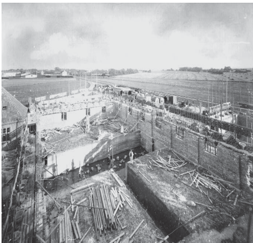
Sukkerraffinaderiet i Valby under opførelse i 1920'erne. Murene rejser sig på fundamentet lige ved jernbanen. I baggrunden marker, og længst ude Kalveboderne.
