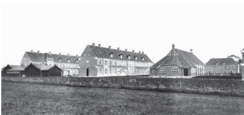
Avedørelejren stod færdig i 1912. På billedet ses fra venstre de to belægningsbygninger, gymnastikhuset med soldaterhjem og kompaniadministrationsbygningen. Bygningerne var grundmurede på sokkel af pudset beton. Murværket var røde håndstrøgne teglsten.
