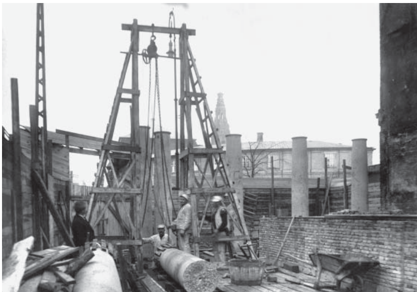
Fra Nationalmuseets ombygning i 1930'erne. Hejseværk til rejsning af søjlerne til søjlegangen. I baggrunden Slotsholmen med ridebaneanlægget og Christiansborgs tårn.
