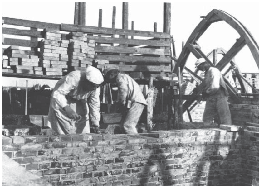
Murere med sten og mørtel ved opførelsen af Filipskirken, som Arnung & Kornerup byggede 1922-24.
