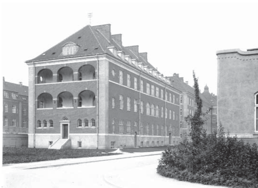
Rigshospitalets børneafdeling kort efter opførelse i 1909. Gavlen er udført med en overdækket loggia, der stod i forbindelse med to 10-sengssale på 1. og 2. etage, der rummede henholdsvis spædbørnsafdelingen på 2. etage og afdelingen for børn over 1 år på 1. etage.
