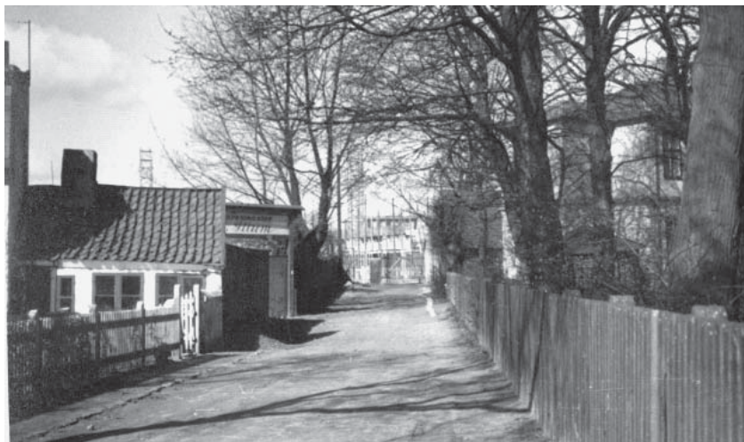
Gadekærvej i Valby med begyndende etagehusbyggeri for enden af vejen.
