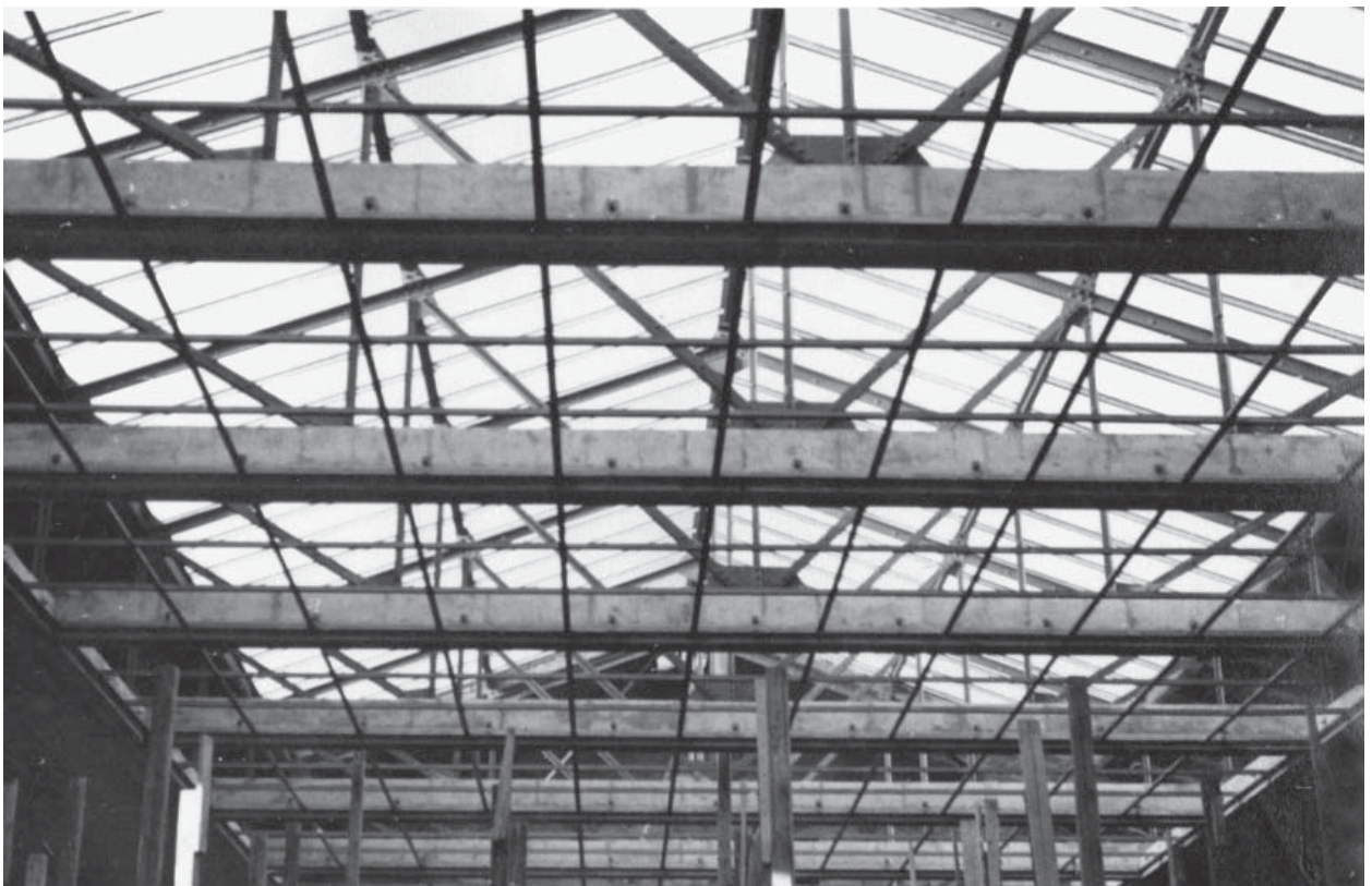
Tagkonstruktion på Frederiksberg Bibliotek.
